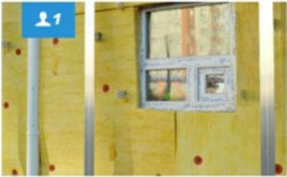
Po novem bo za subvencijo treba na fasadi vgraditi več toplotne izolacije
