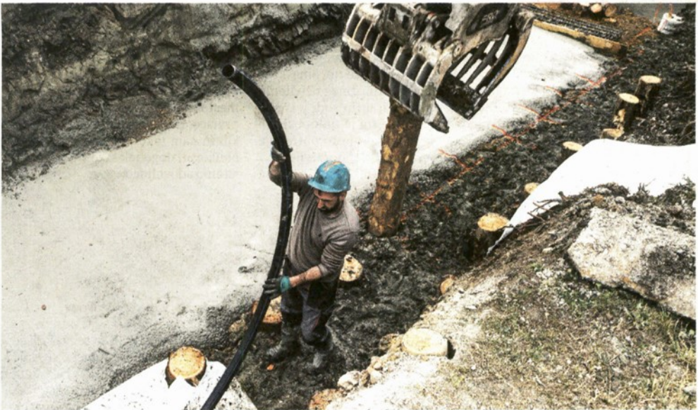
Prenova ceste skozi Črno vas, pod katero so gradbinci zabili kar 17.000 lesenih in betonskih pilotov, naj bi se končala nekaj mesecev pred rokom. Bojan Velikonja DOCUMENTALNA DNEVNIKA
