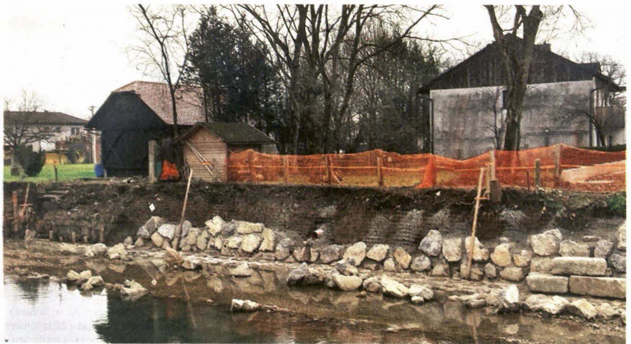
Tako kot občino pri kanalu C0 tudi direkcijo za vode pri projektu Gradaščica priganja rok 31. december, sicer bodo ogrožena evropska sredstva. 📷 Vanja Brkić
